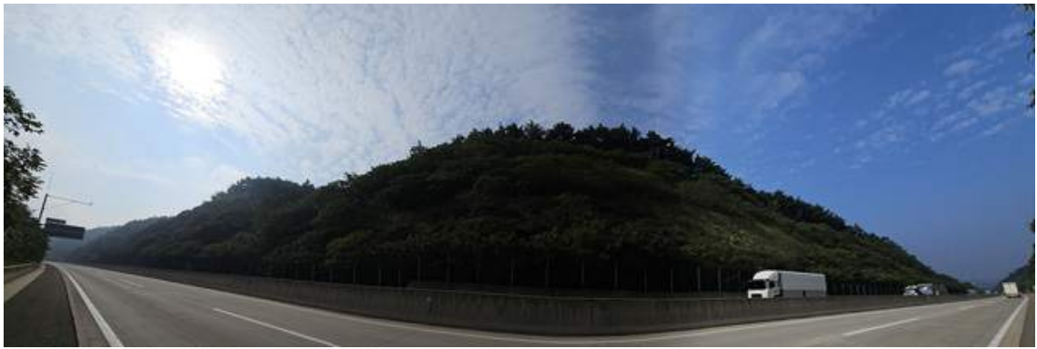
영천절토 38 (관리이정 54.478~54.928km / 6공구 STA.10+260~10+710)
