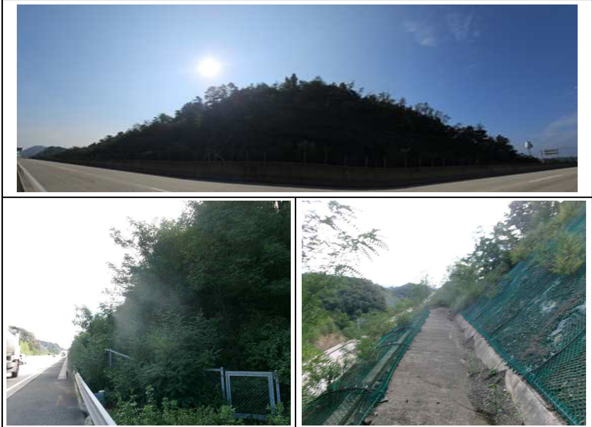
영천절토 45 (관리이정 69.078~69.258km / 8공구 STA.3+720~3+900)
