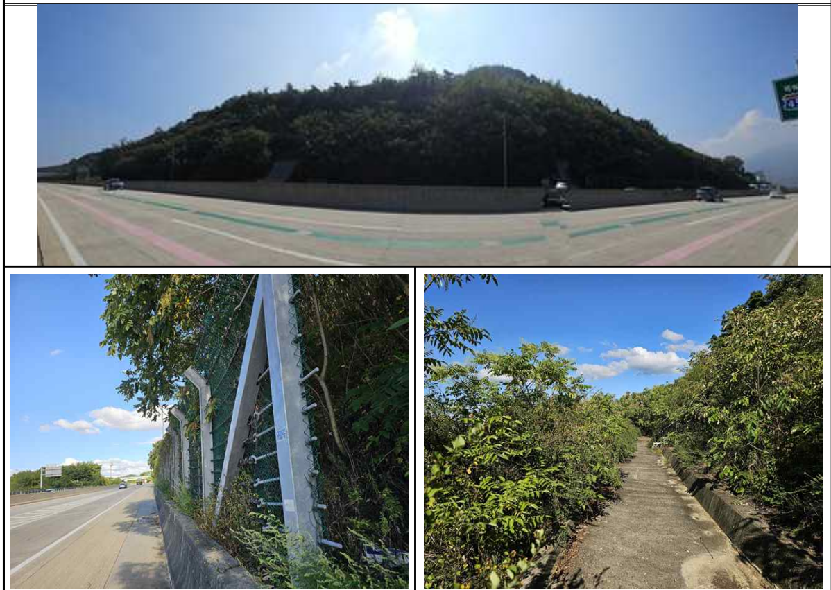
영천절토 01 (관리이정 1.000~1.400km / 1공구 STA.1+000~1+400)
